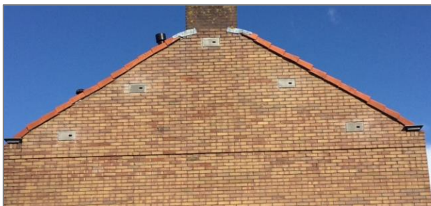
Afbeelding 7.8 | Voorbeeld van een kopgevel met ingemetselde nestkasten voor gierzwaluwen.
